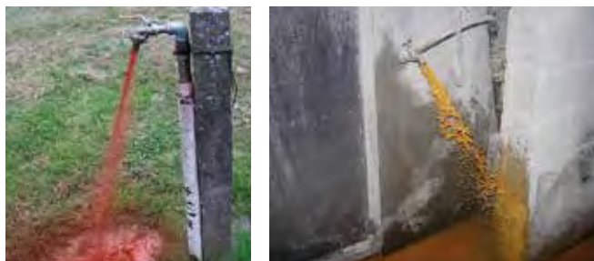
Photos 1 et 2 : réalisées lors de décapage des canalisations avec le système APIRE®
