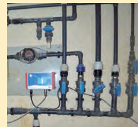
Le tube Aqua-4D® est inséré sur la canalisation principale
